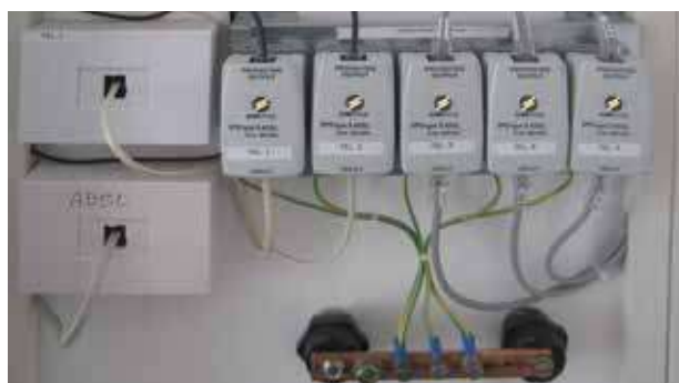
Esempio di protezione per fonia e trasmissione con scaricatori S ADLS
