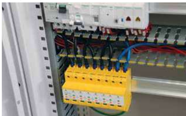
Esempio di protezione con CB di linea \leq 160 A
