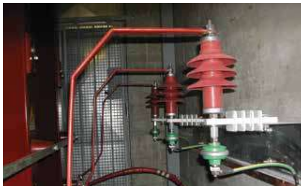
Esempio di protezione sistema MT del trasformatore MT/BT con scaricatori ZU HV 24.2
