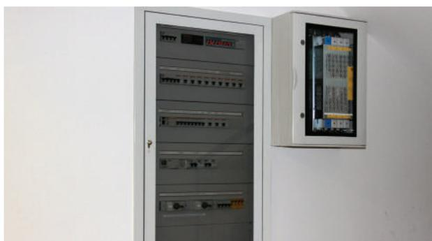
Esempio di protezione per fonia e trasmissione con scaricatori S ADLS
