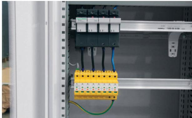
Esempio di protezione con CB di linea  $\leq 160$  A
