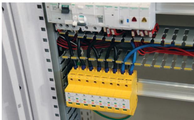
Esempio di protezione di circuiti di segnale e di un alimentatore con scaricatori ILF 2P 32 e S-ASI 24
