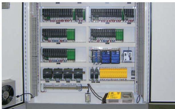
Esempio di protezione di un quadro CED già esistente di medie dimensioni con scaricatori ILF 4P 250
